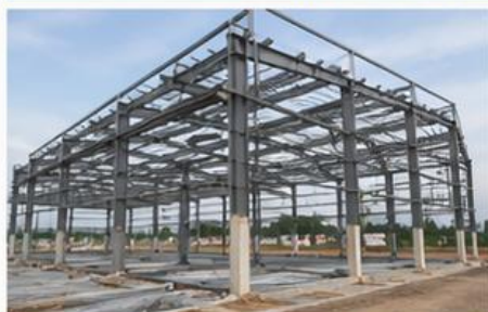
THI CÔNG NHÀ XƯỞNG – NHÀ THÉP TIỀN CHẾ
