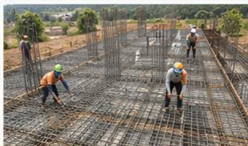
THI CÔNG HẠ TẦNG KỸ THUẬT
